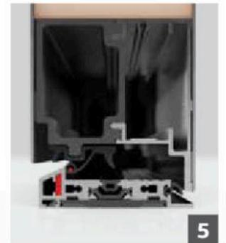
Dichtung Magnet WeatherSeal
